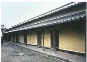
Nagayagura - Long Storehouse
